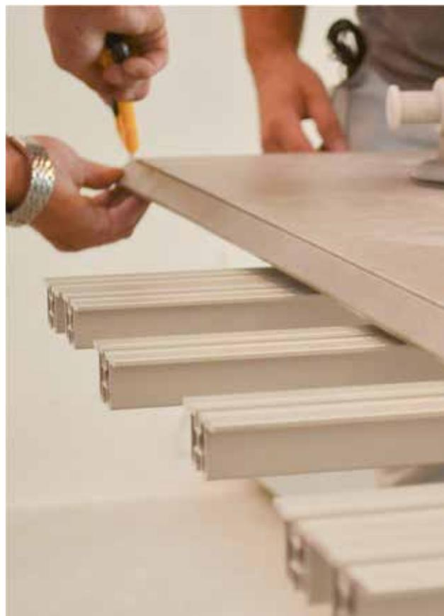
Con las pinzas cortadoras de trefilados, comenzar a separar por los dos extremos y siguiendo la línea precorte borde de la mesa y realice un movimiento único hacia abajo para provocar la factura.
