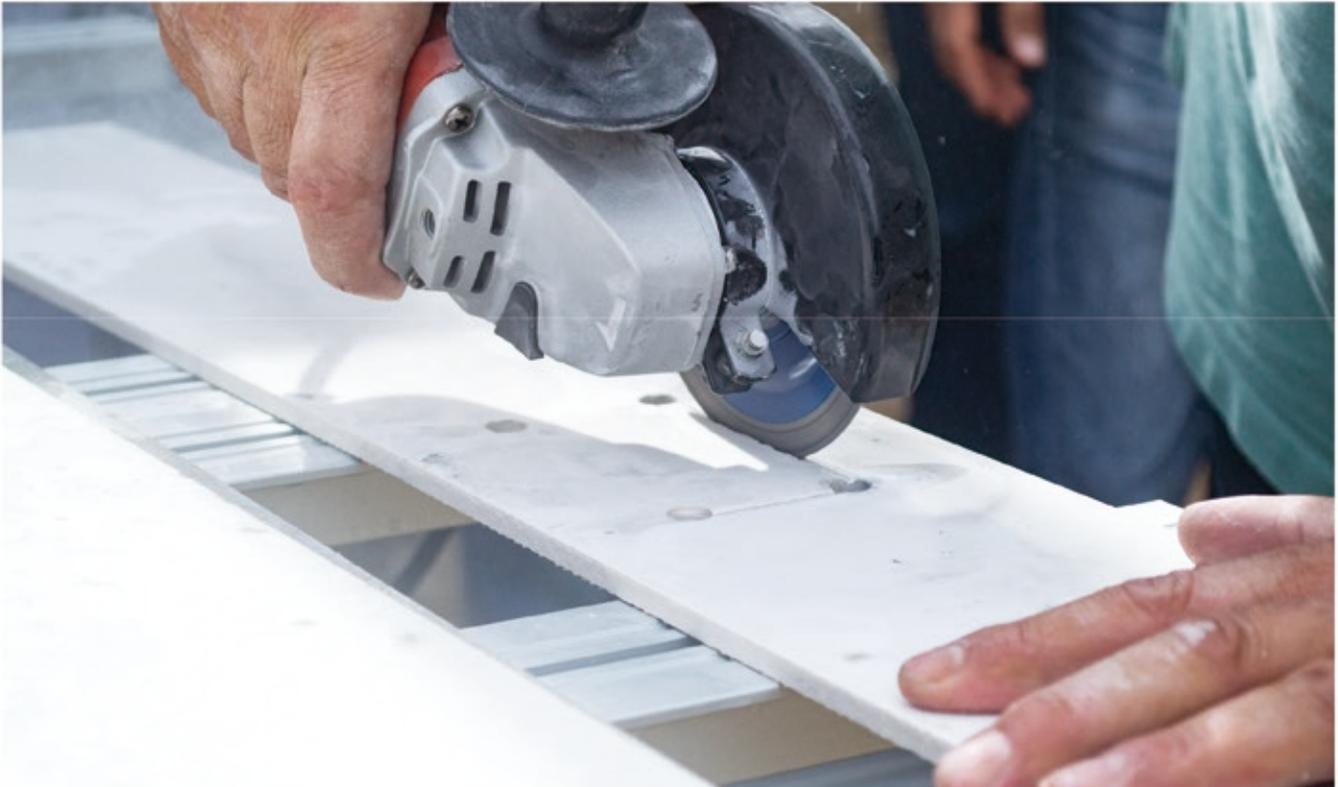
Con una pulidora equipada con un disco diamantado especializado de corte fino como Groza profesional Silver de 125 mm, corte una de las líneas trazadas entre cada perforación.
