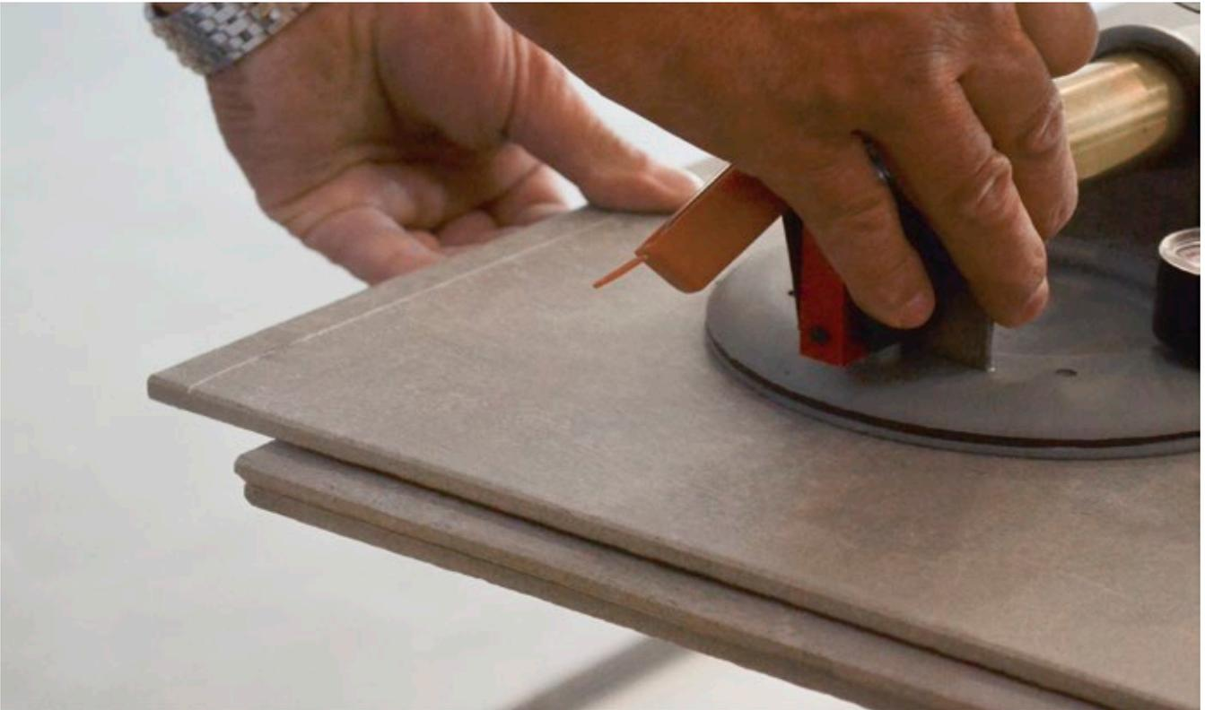
Una vez efectuado el corte, mover la baldosa de tal manera que la línea de tallado sobresalga 10 cm del plano de apoyo.
